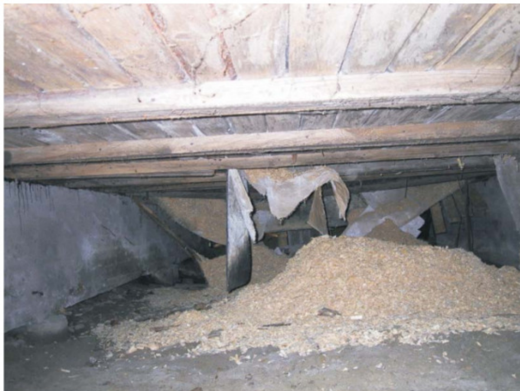
Tyypillinen vaurio alapohjan nurkasta, tuuletuskatveesta.
